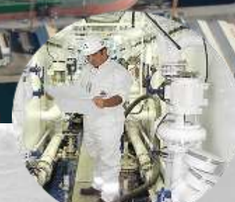
Taller Calderas y Cañerías
